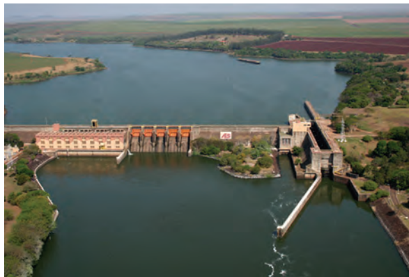
(Retirado de <http://www.istoqui.com.br/2011/12/manutencao-em-eclusa-de-barra-bonita/>. Acesso em 15/08/2013)
